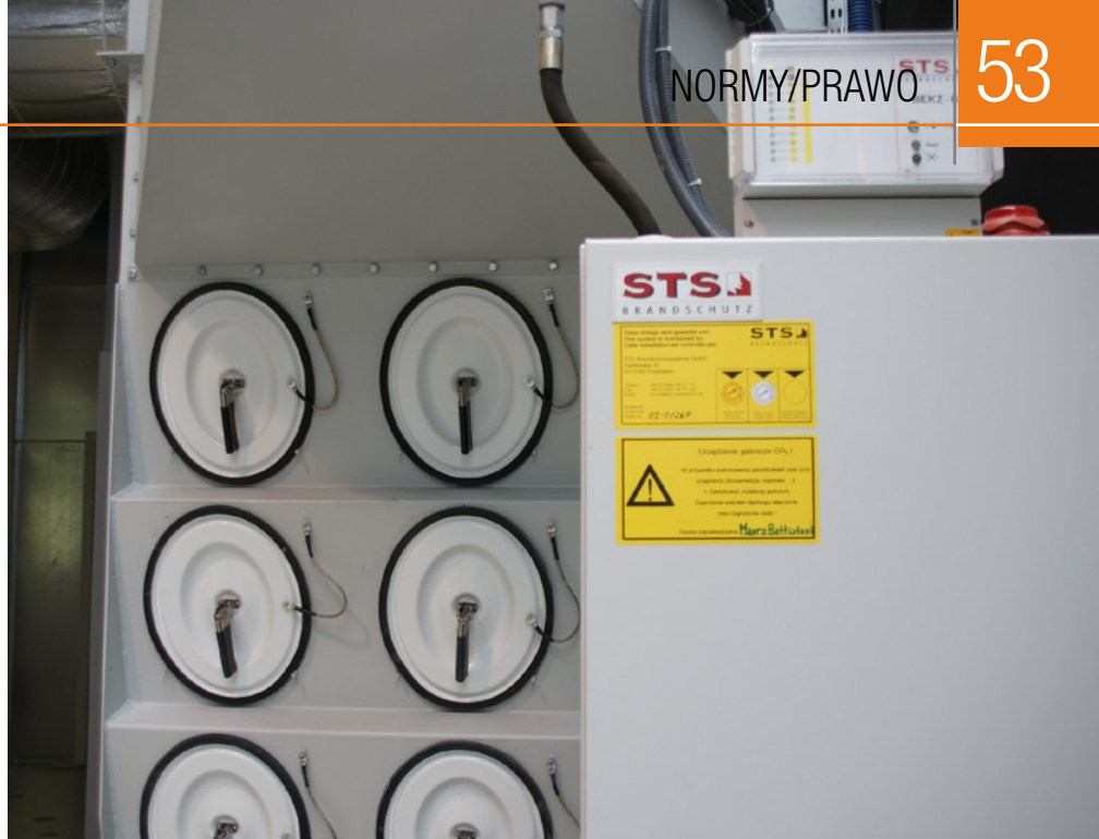
Zgodnie z zaleceniami przepisów europejskich ATEX system lakierniczy powinien być wyposażony w automatyczny system wykrywania i gaszenia ognia - STS. Na zdjęciu lakiernia w firmie Best Poland z Zabrze.
